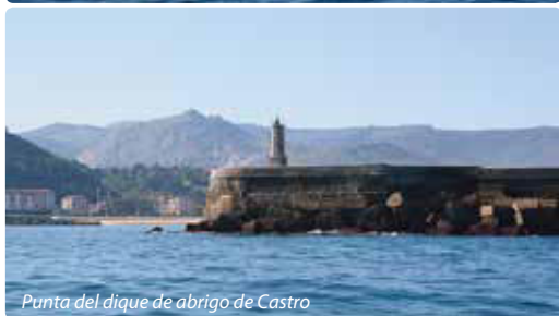
Punta del dique de abrigo de Castro
