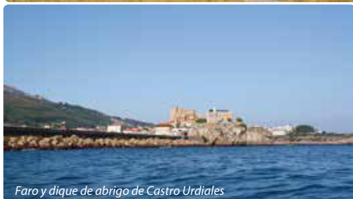
Faro y dique de abrigo de Castro Urdiales
